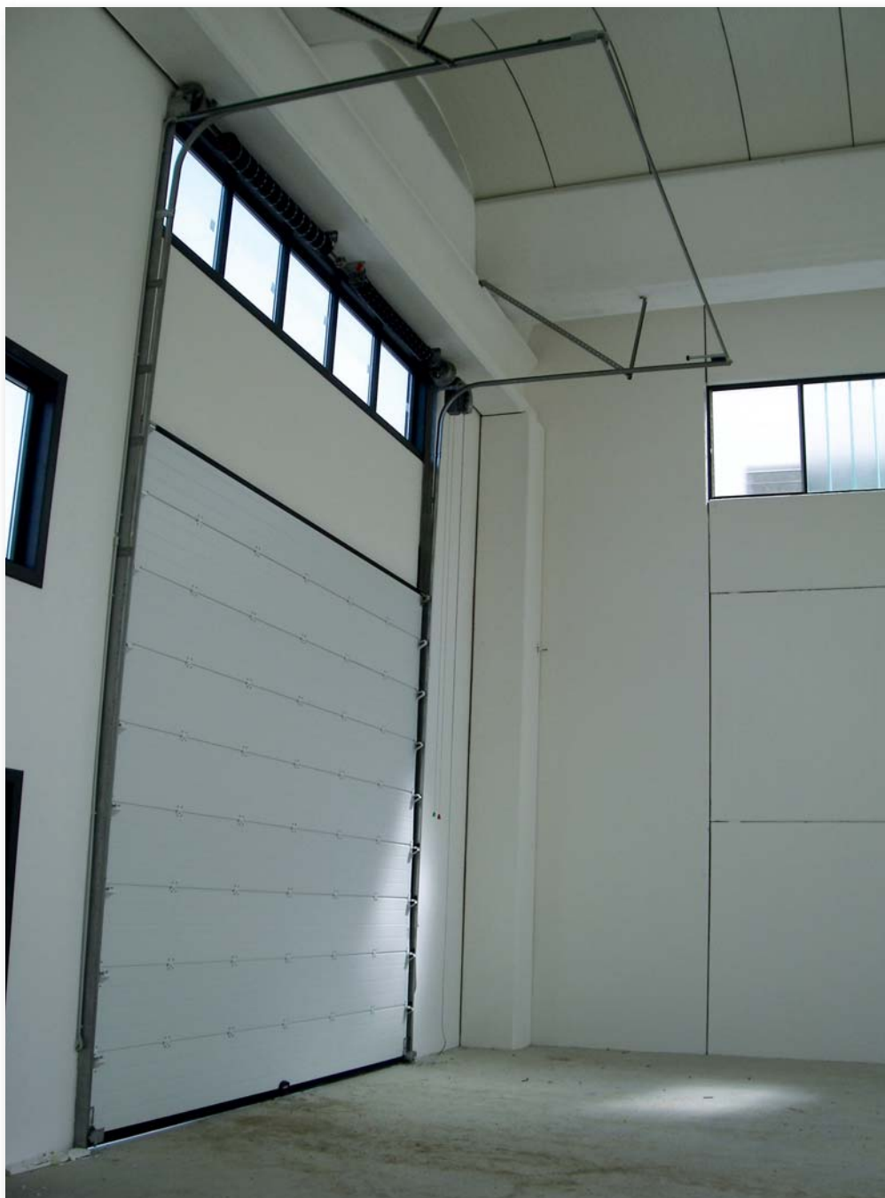
Porta sezionale parzialmente verticale con motore a palo serie LATO, vista interna
