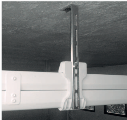
Staffe fissaggio a soffitto
