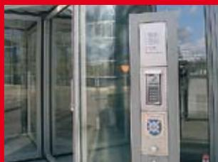
**Controllo d'accesso.** In questo modo si ha il controllo delle persone che accedono all'edificio. Sono previsti sistemi d'identificazione tramite badge, chiave o altro.
